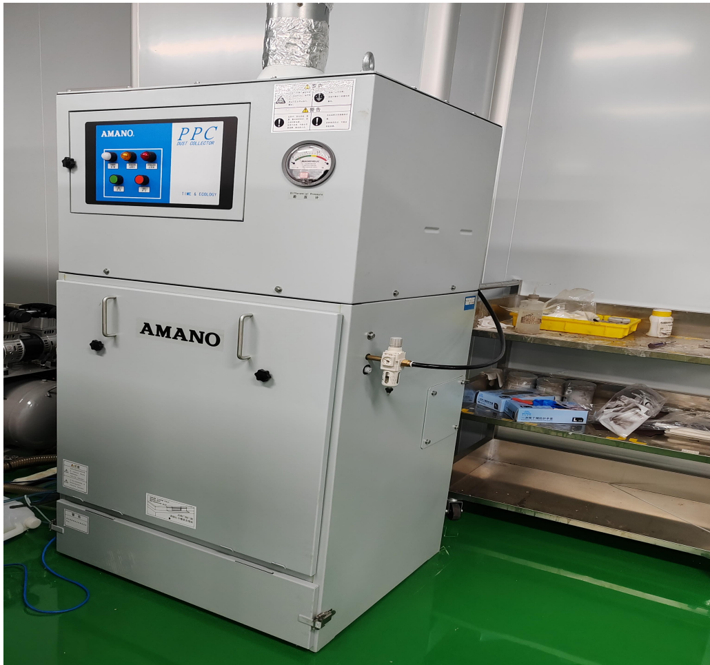
图 3.1-4 迁建项目废气处理设施（烟尘回收装置）图片
