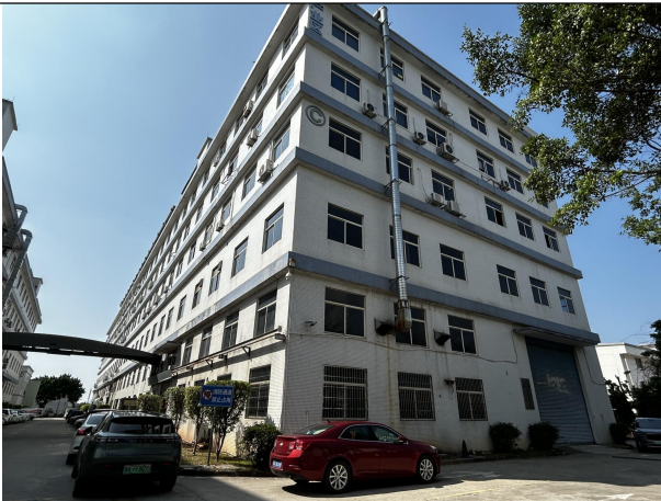
西面：园区 C 栋厂房
