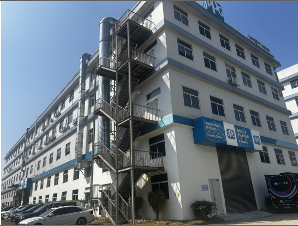
西南面：园区 D 栋厂房
